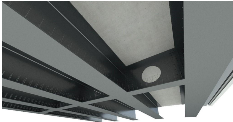
Figure 16 : Vue du dispositif anti-oiseaux, constitué de piques en acier inoxydable disposées le long de la structure (poutres et entretoises)
